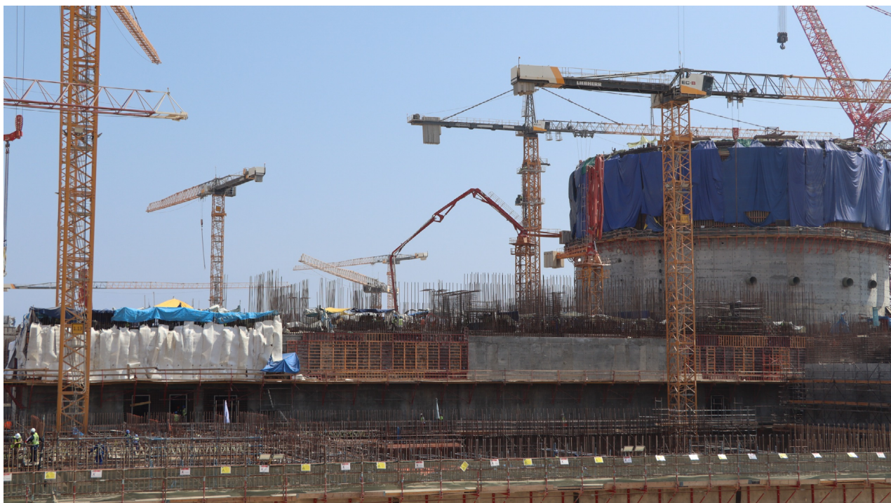
Строящийся блок № 1 АЭС «Эль-Дабаа», Египет.
