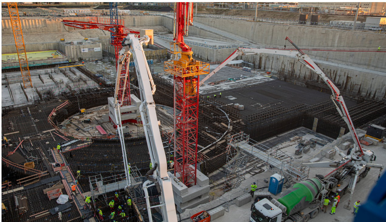
Начало строительства фундаментной плиты реакторного здания блока № 5 АЭС «Пакш-2». Источник: Paks II Atomeromu Zrt.
