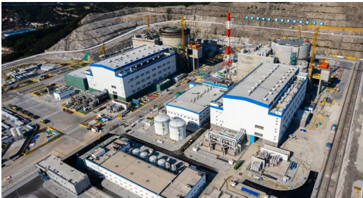
Блоки № 7 и 8 АЭС «Тяньвань» в Китае. Источник: CNNC
