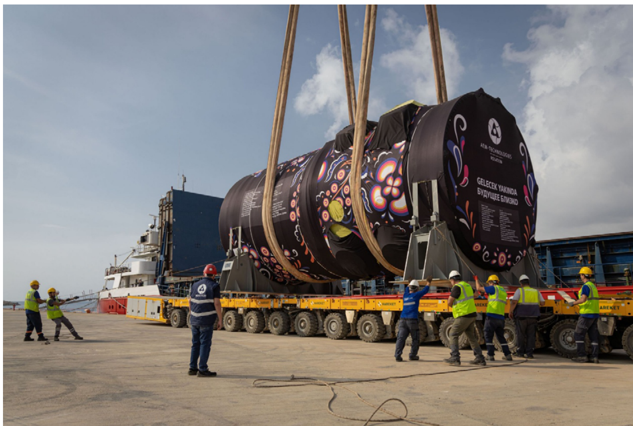
Доставка на площадку АЭС «Аккую» корпуса реактора для 4-го блока. Источник: АтомМедиа
