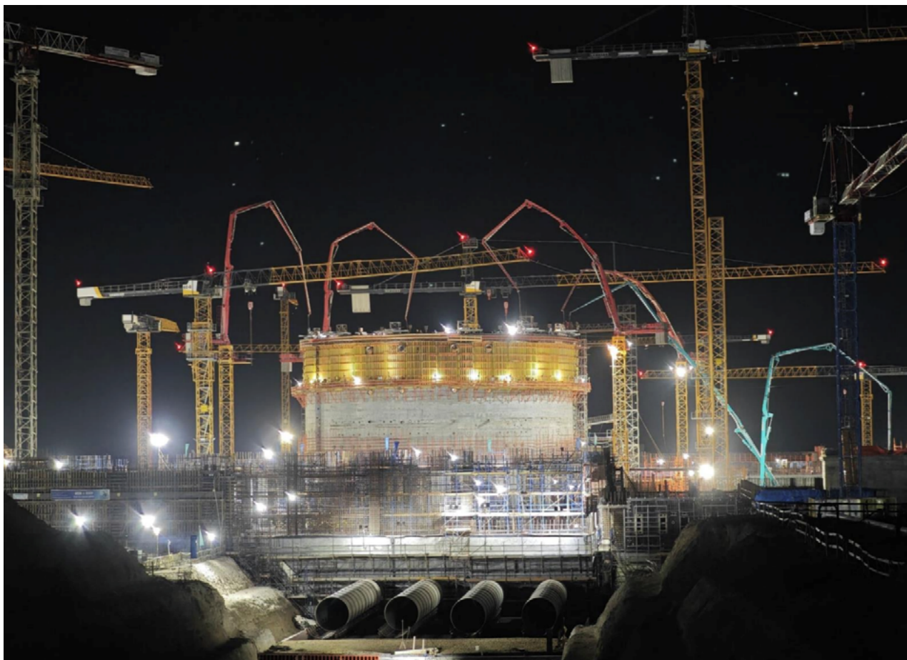
Строящийся блок № 2 АЭС «Эль-Дабаа», Египет. Источник: АО «АСЭ»
