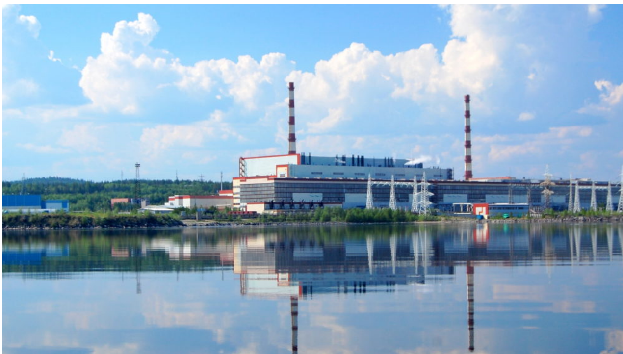
Кольская АЭС, Полярные Зори, Мурманская область.
