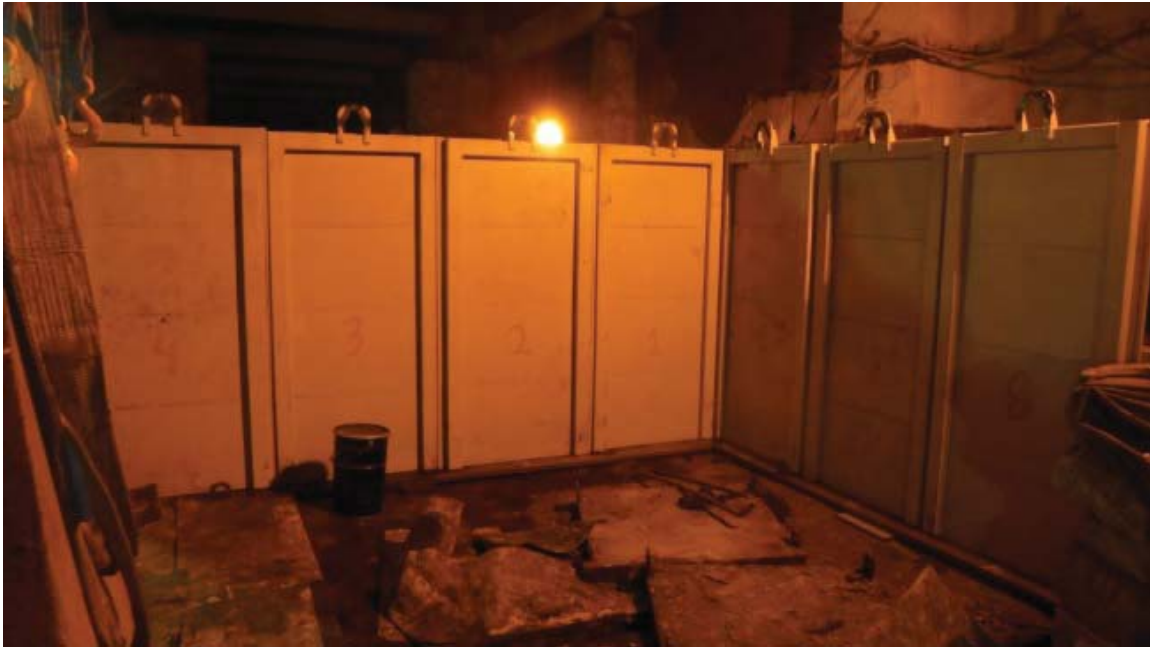
Установленная вертикальная биологическая защита в бассейне здания № 5.
