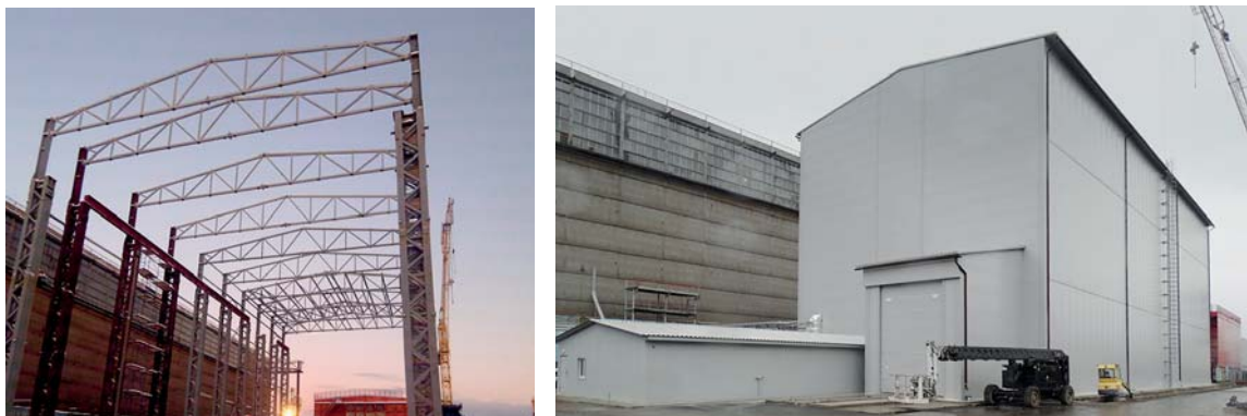
Строительство защитного сооружения (здание-укрытие).
