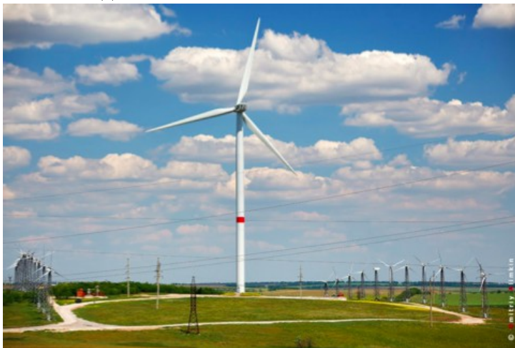
Рисунок 2 – Ветроэнергетическая установка мощностью 2.5 МВт. (На рисунке можно сравнить размеры ВЭУ с размерами всем известных опор высоковольтных ЛЭП)
