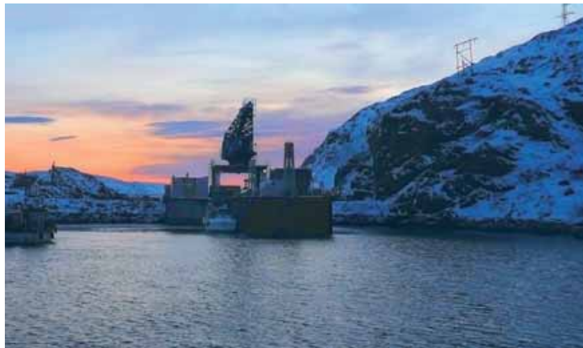
Кислогубская приливная электростанция (фото: ОАО «Малая Мезенская ПЭС»)
