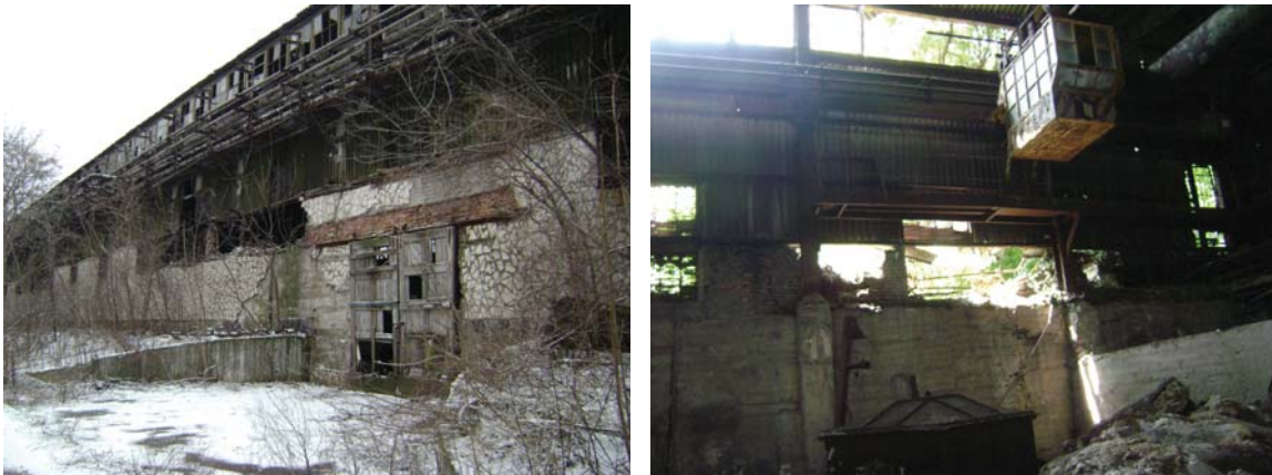
Рис. 35. Будівля № 1. Колишній склад уранової сировини
