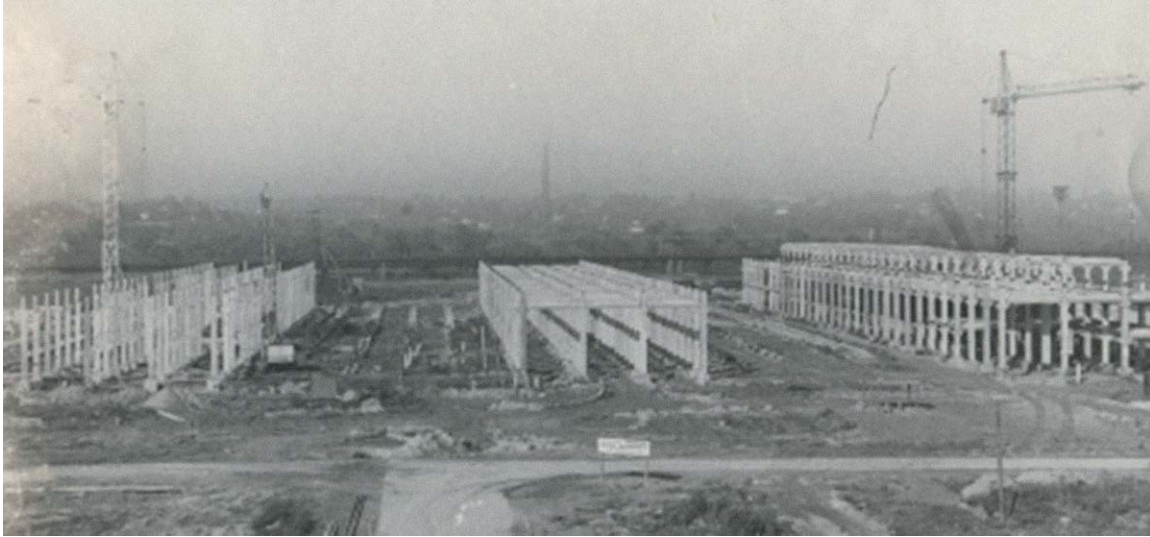
Рис. 1. Початок будівництва цехів ПХЗ (фото — стаття «Завод № 906», газета «Атомник України» № 36 (875) від 07.09.2017 р. Автор А.П. Мухачев)
