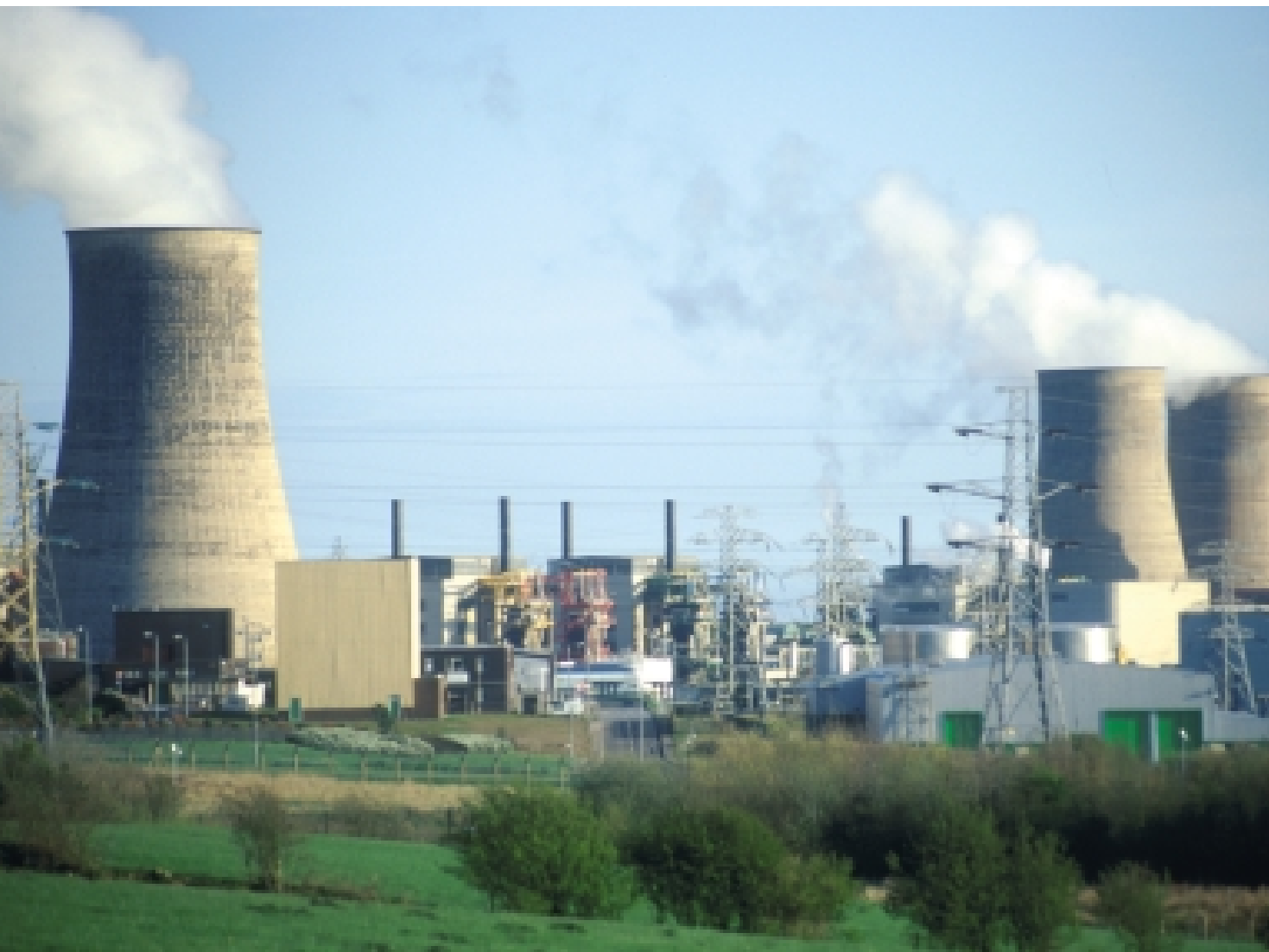
Det er fire Magnox-reaktorer i Calder Hall kraftverket. Bildet er tatt i 1998 da alle reaktorene fremdeles var i drift.
