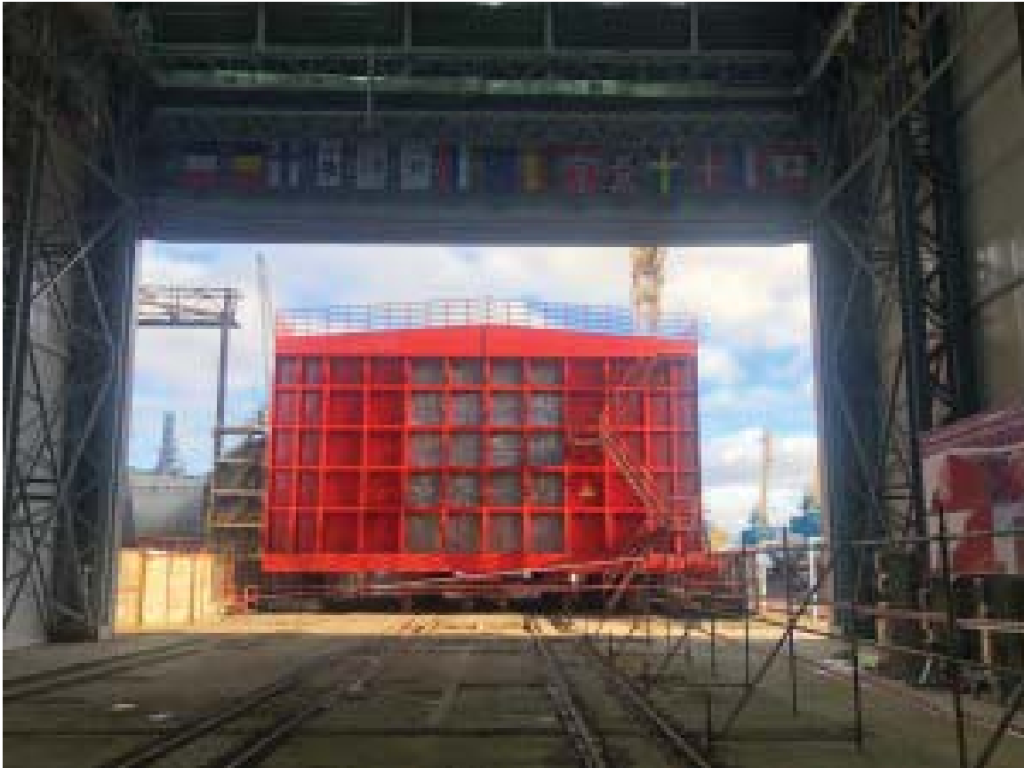
Рис. 15, 16. Носовая блок-упаковка и здание-укрытие
